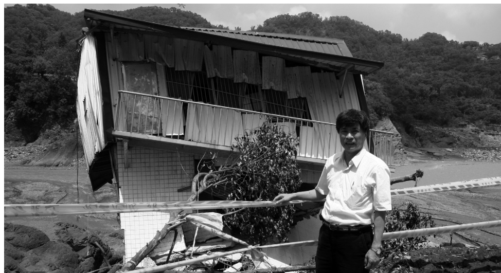
◆高雄縣六龜鄉荖濃溪上游的興龍村遭受土石流沖刷後半傾倒的屋舍。
