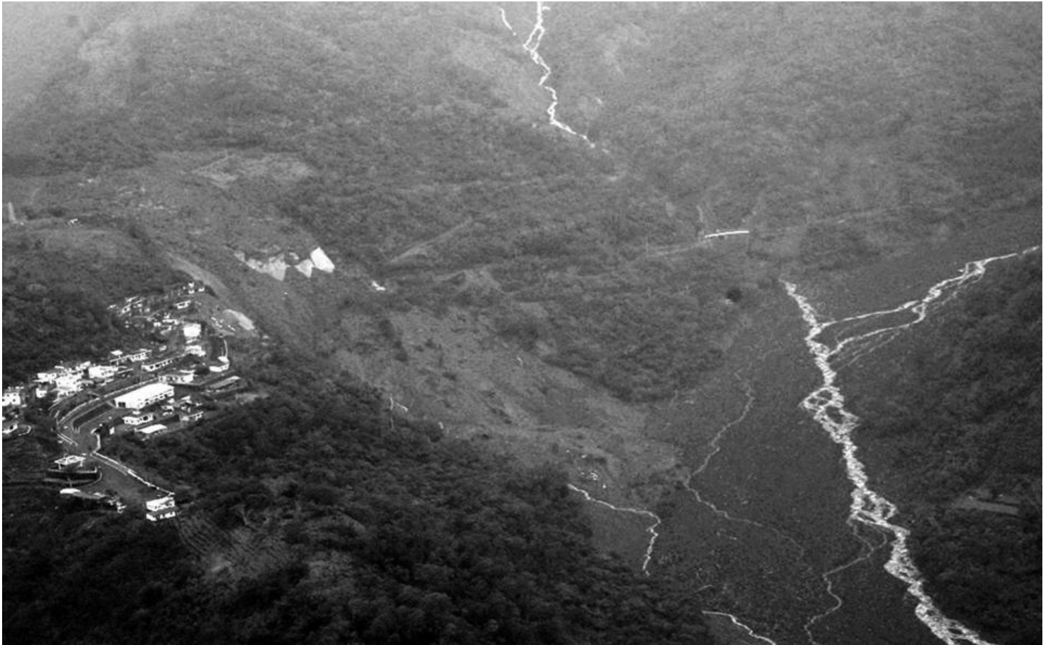
◆屏東縣霧台鄉在莫拉克颱風中受到重創，圖為霧台鄉佳暮村，上方崩塌處是對外連絡道路，完全埋在土石裡，部落下一整片的山林被土石流淹沒。
