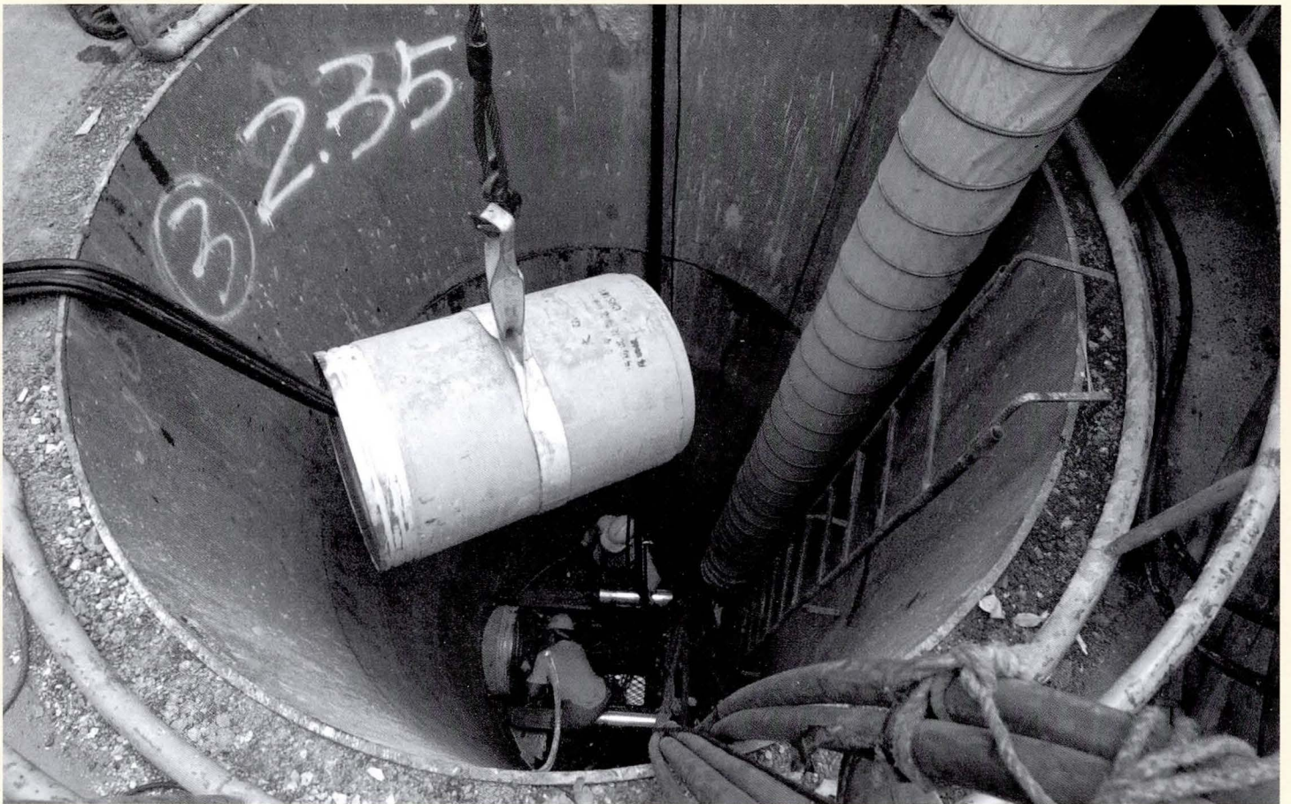
◆污水下水道工程建設實景。
