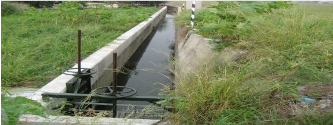
圖 27 舊圳圳路渠道
