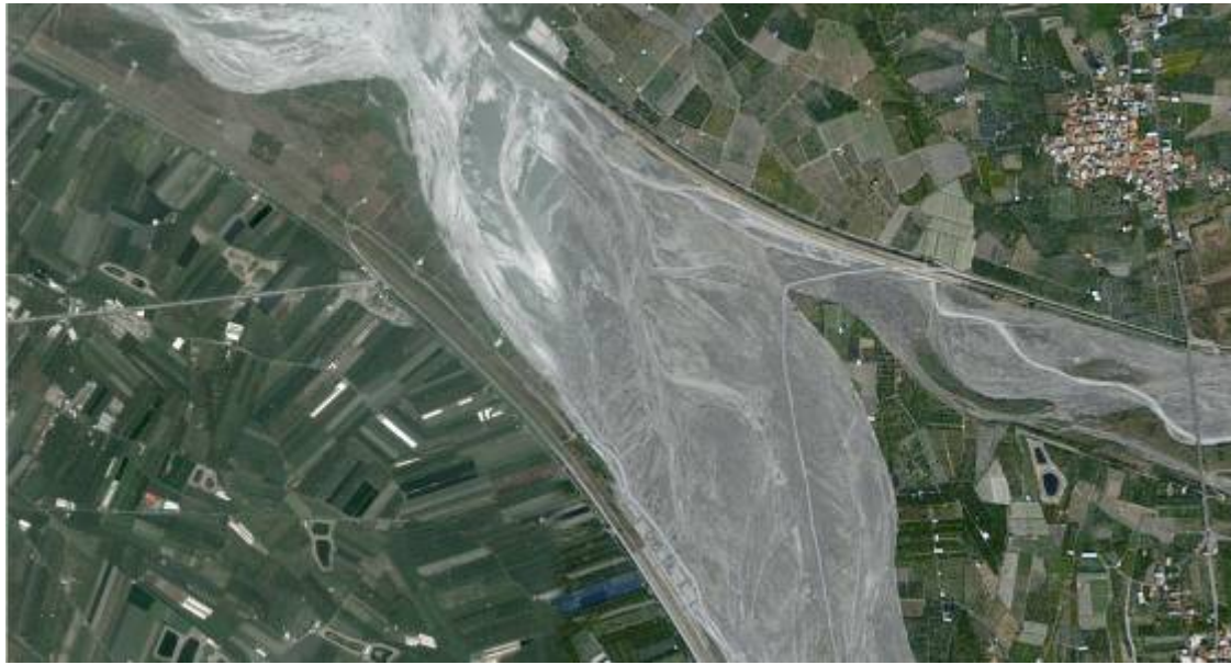
照片 1 隘寮溪隘寮堤防與大陸關堤防段
