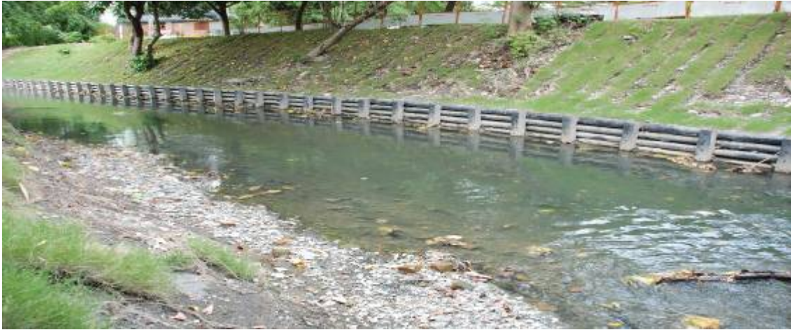
圖 4 植樁植生護坡工
