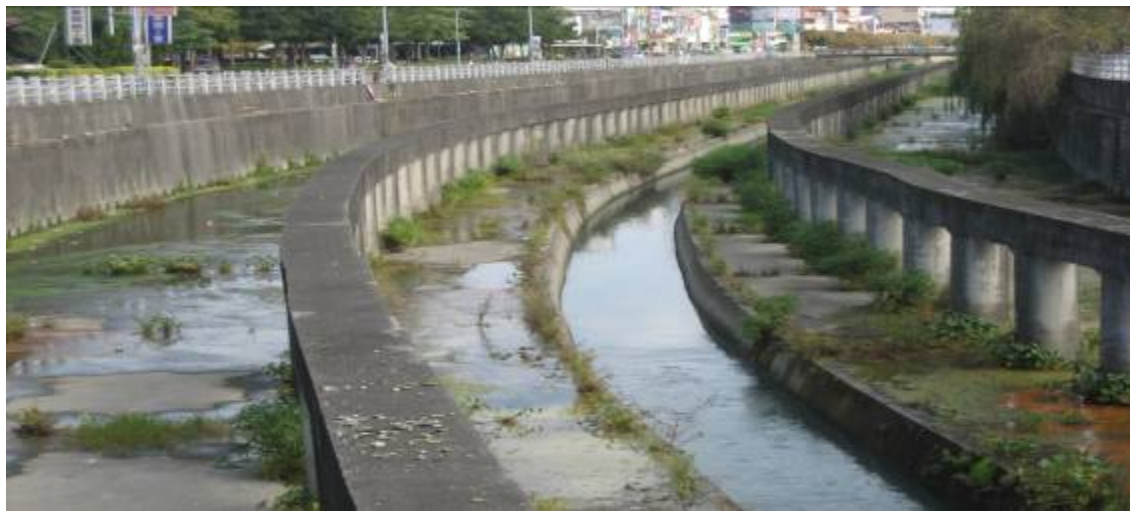
圖 5 渠道混凝土三面
