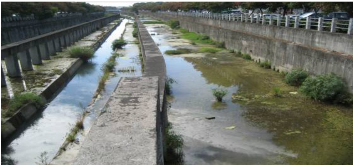
圖 2 混凝土三面光
