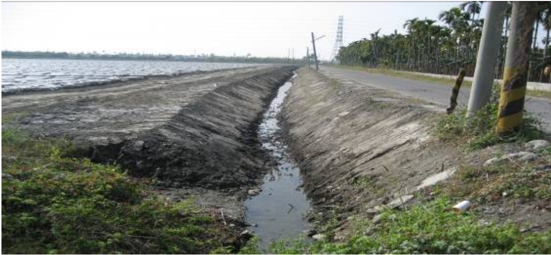
圖 19 海豐老圳引水渠
