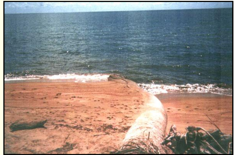
沙腸突堤工法 (澳洲飛魚岬海岸)
