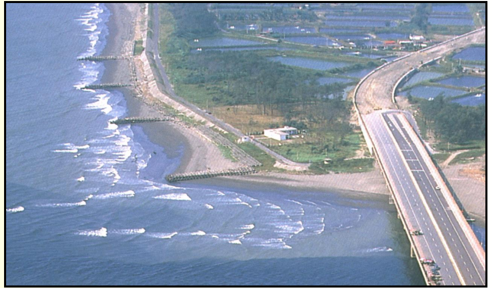
台南鹽水溪口之突堤群
