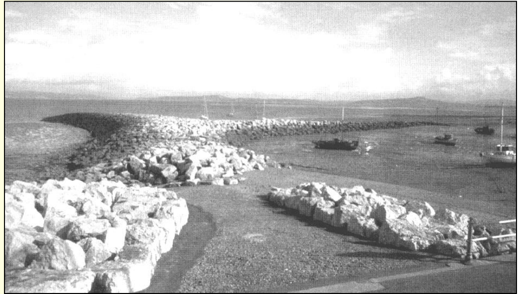
英國 Morecambe 海岸魚尾型防波堤現場實例
