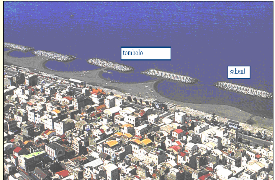
高雄茄定海岸離岸堤
