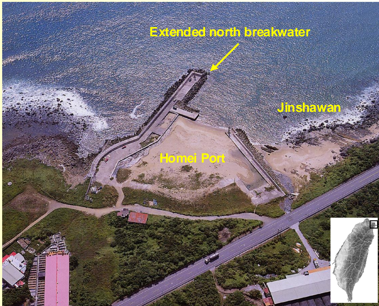
台北縣和美漁港港池淤沙與金沙灣海灘侵蝕
