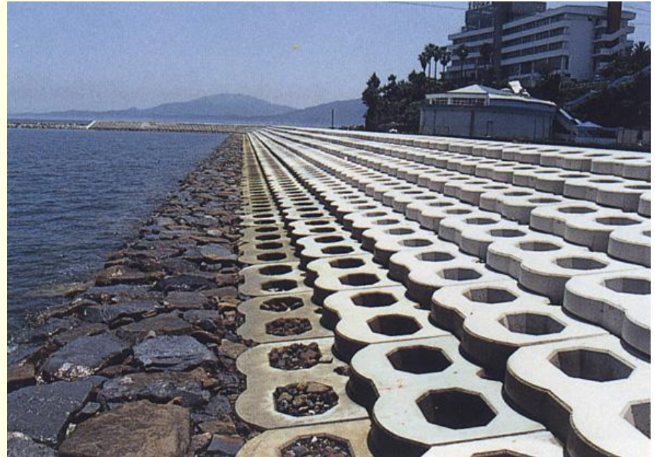
日本熊本縣茂木根港海堤
